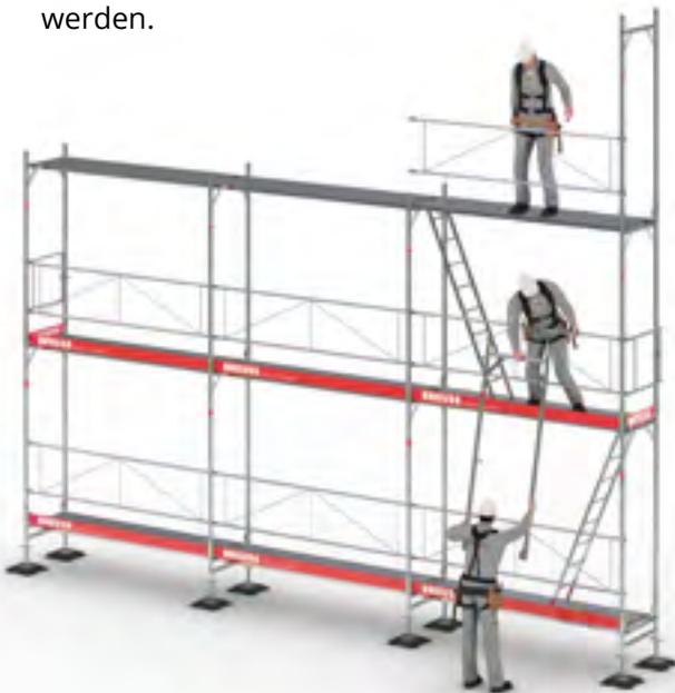
**Bild 18a:** Oben steht ein Arbeiter, der auf den Rahmen wartet und das Geländer schon eingehängt hat
